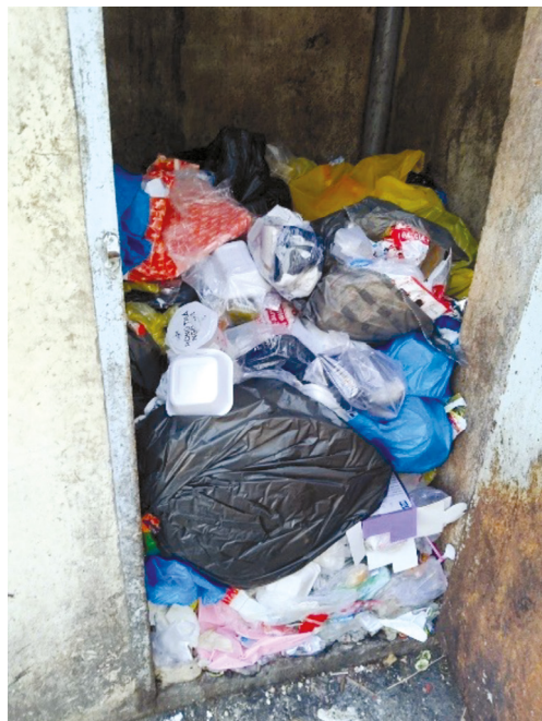
Hình 3. Nhà chứa rác tích tụ rác thải.
